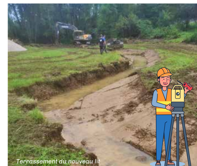
Vue d'une partie du linéaire
