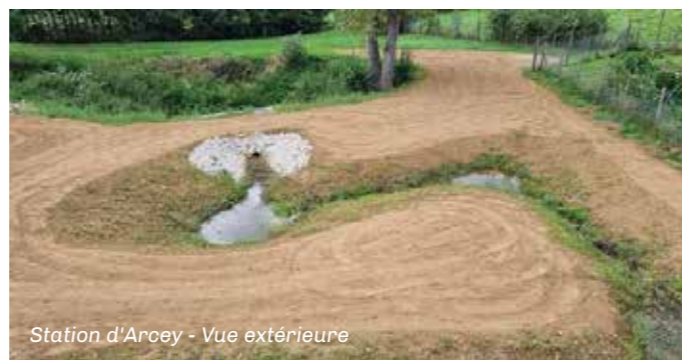
Vue d'ensemble de la nouvelle station d'Arcey
